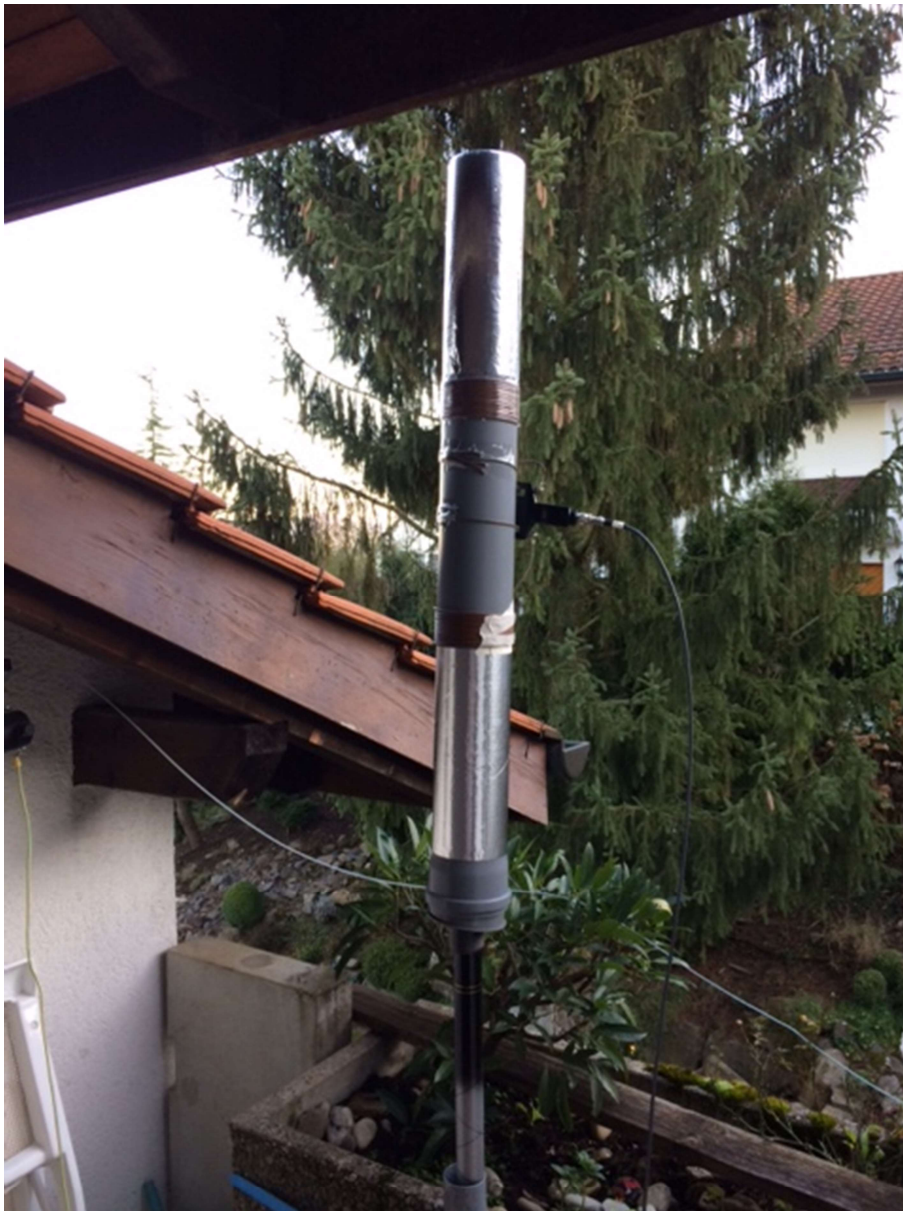
Abbildung 5 Erster Test EH-Antenne 40m "out door"
